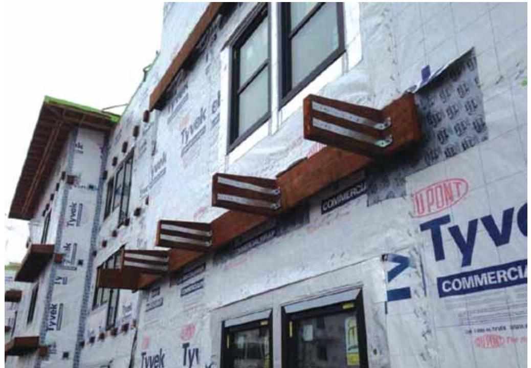
**Slika 3.13.** Jednostavne jeftine fiksne tende i način njihovog postavljanja imajući u vidu toplotne mostove (Passivehouse Kanada)
