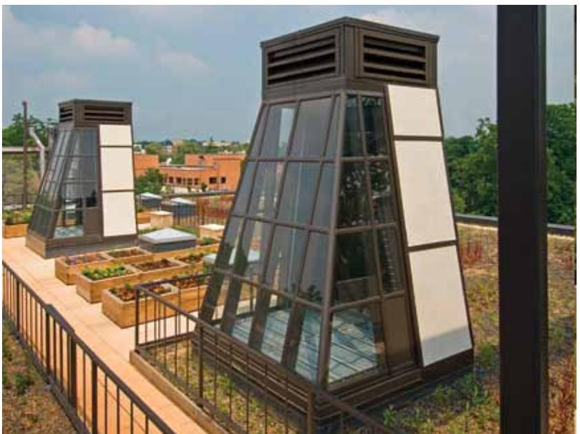
**Slika 6.4.** Solarni dimnjak(c) kao način za povećanje strujanja vazduha za potrebe pasivnog hlađenja
