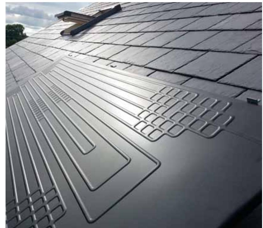
**Slika 6.3.** Termodinamički solarni panel
