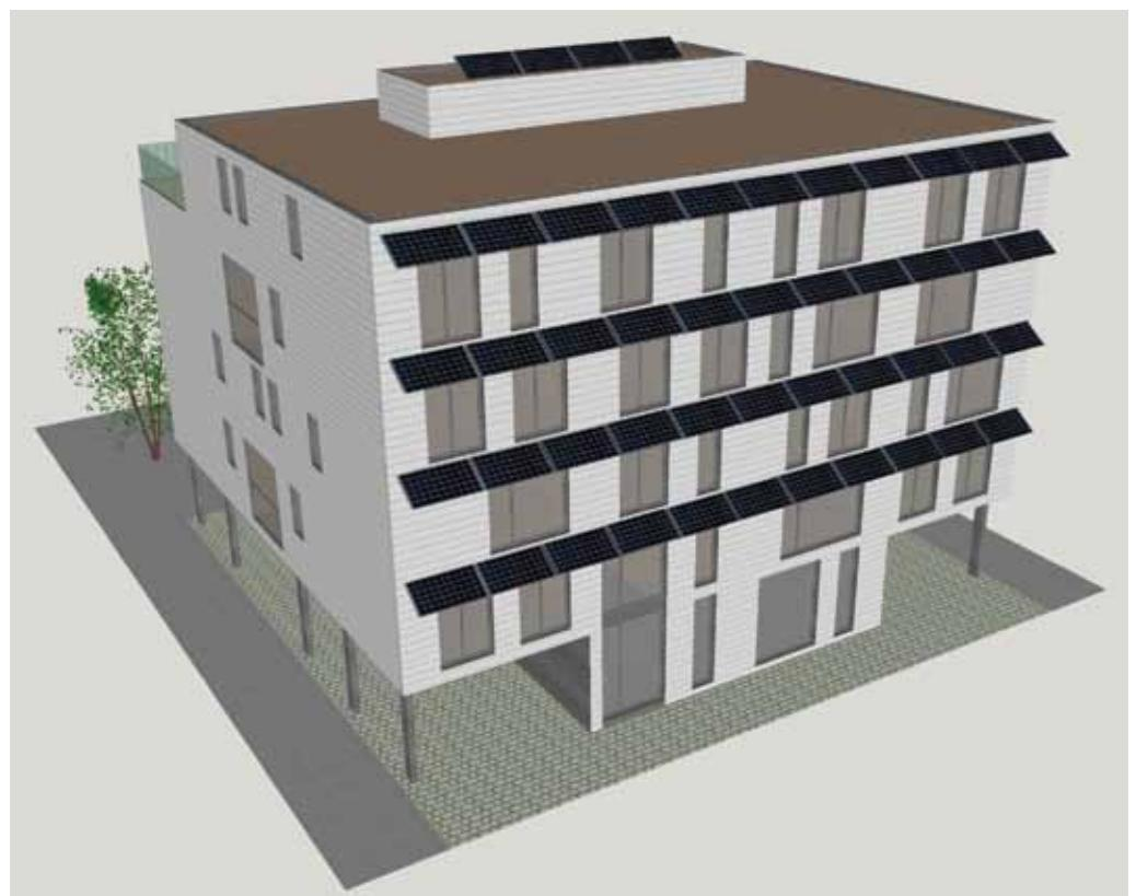
**Slika 3.15.** Fotonaponski paneli kao zaštita od sunca na južnoj fasadi
